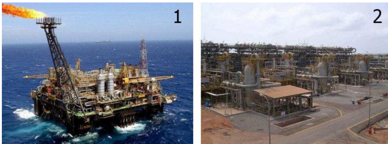
Рис. 3- 1. Технологическая платформа с оборудованием для подготовки нефти и газа. 2. Наземные установки обезвоживания природного газа и регенерации ТЭГ.
